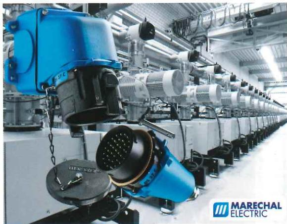
I connettori multicontatti sono conformi alla Direttiva europea Bassa Tensione 2006/95/CE, alla norma di crimpatura NF C20-130 e alla norma dei connettori IEC 61984.
